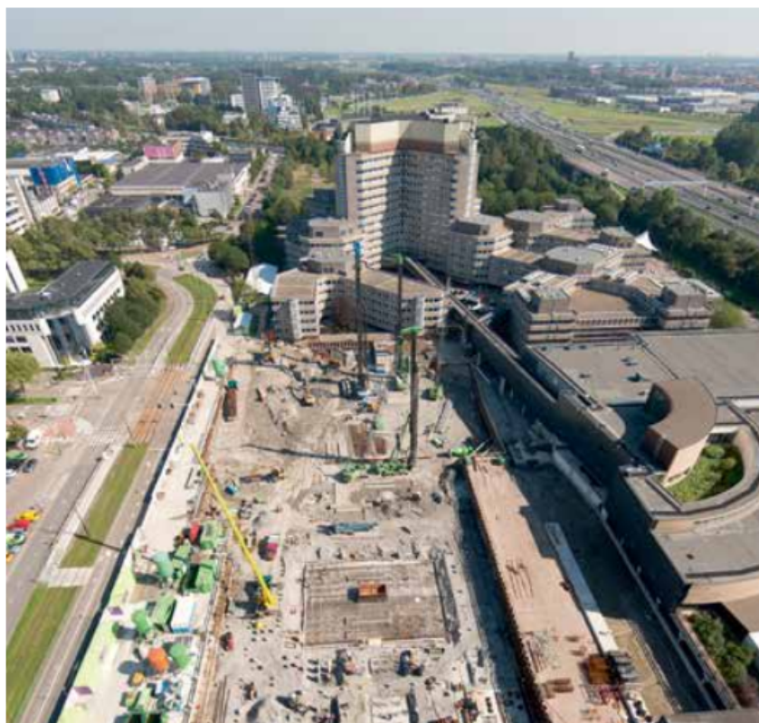
7. Krappe bouwlocatie. Aan de bovenzijde tegen de bestaande bebouwing is eerst het nieuwe ondergrondse energiegebouw gerealiseerd. Rechts is de bestaande Hinge deels gesloopt om aan te sluiten op de nieuwbouw.
