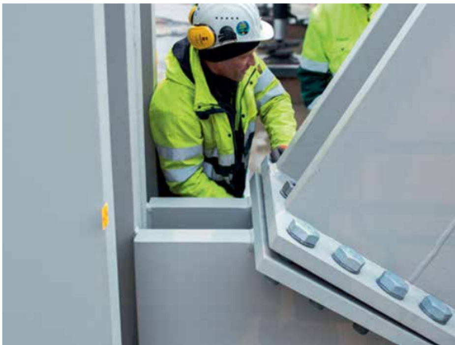
8. Grote knopen, relatief eenvoudige verbindingen.
